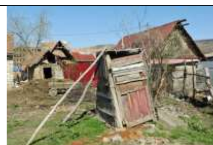
Toiletforholdene kunne vist godt trænge til lidt genopretning!
